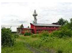
Komín Domu Dětí a Mládeže v Modřanech
