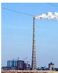
Komín elektrárne GRES-2, 419,7 m
